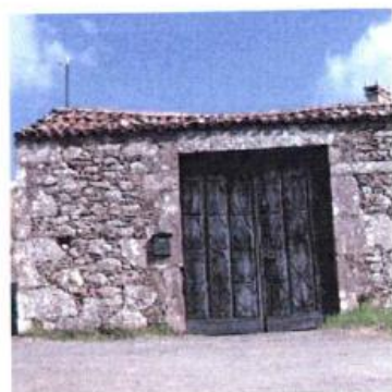
g. cantería en esquineira. h. cantería en ocos.
