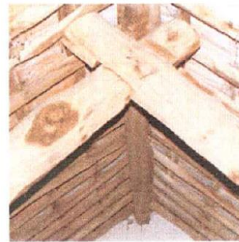
estrutura de cuberta.
