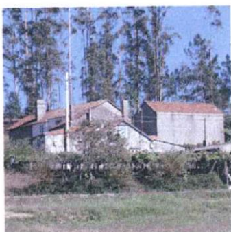
enfoscados de cemento.
