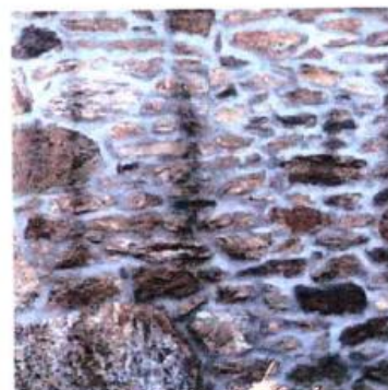
e. cachotería encintada. f. cachotería mixta.
